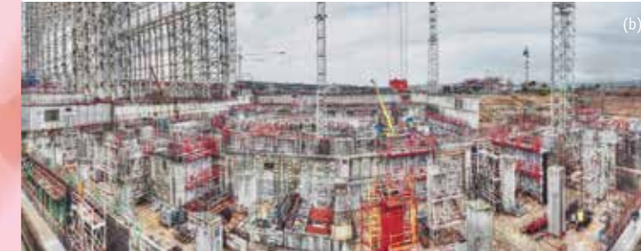
Baustelle des Fusionsreaktor-Experiments ITER im französischen Cadarache
